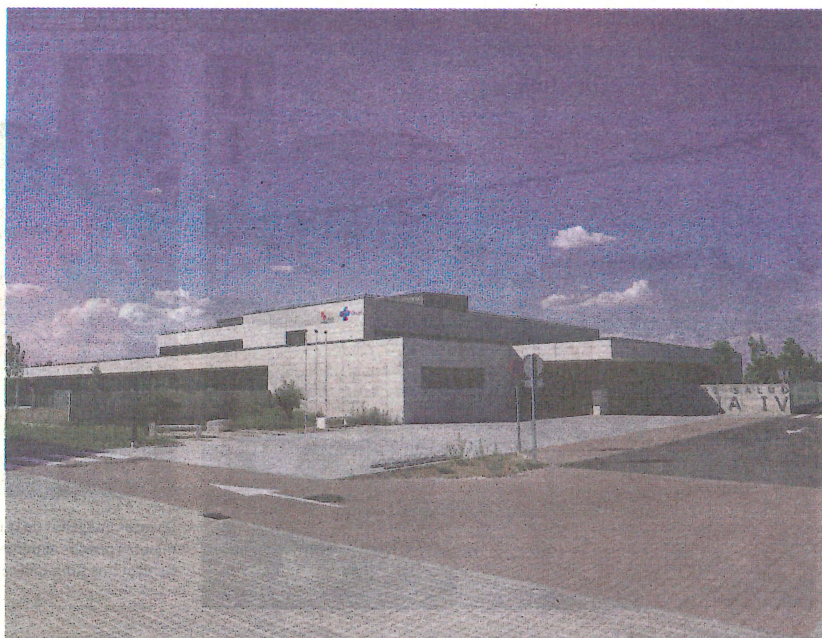
Centro de Salud Segovia IV, ubicado en el barrio de Nueva Segovia.
