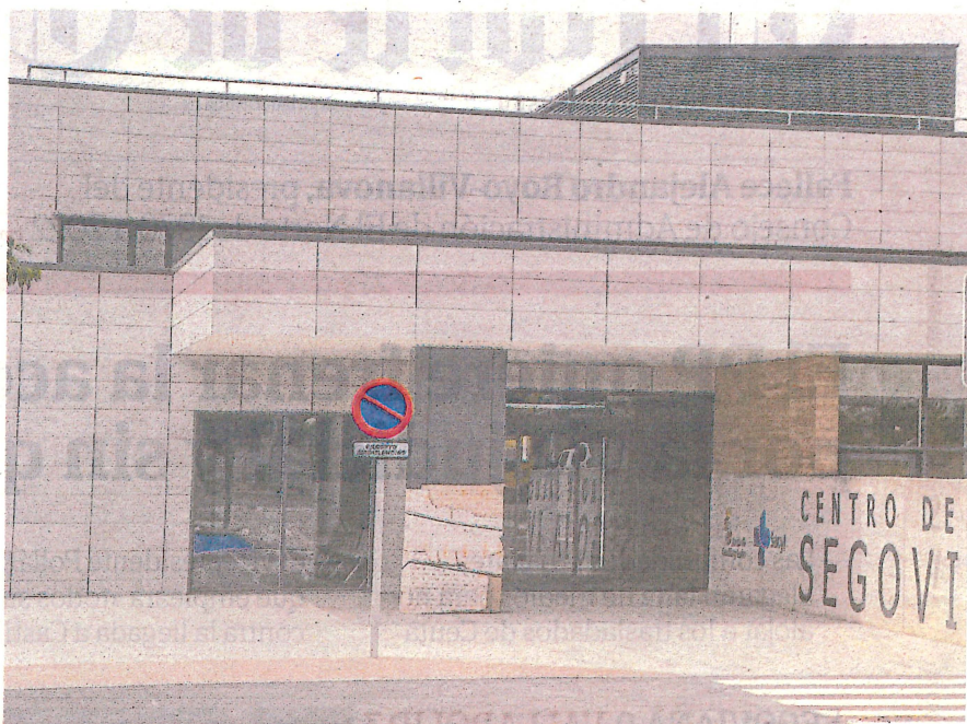
La obra civil del nuevo centro de salud de Nueva Segovia está acabada. ÓSCAR COSTA
